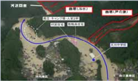
湛水による浸水被害の例 (芦瀬、冷水)
