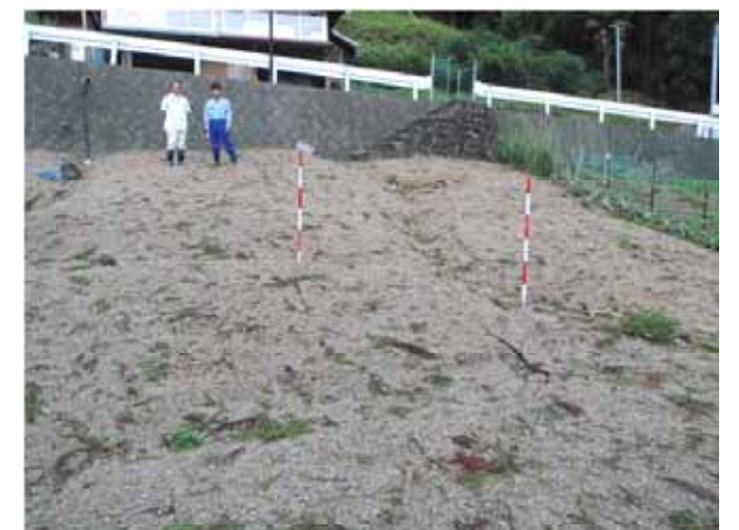
地面のひび割れ
