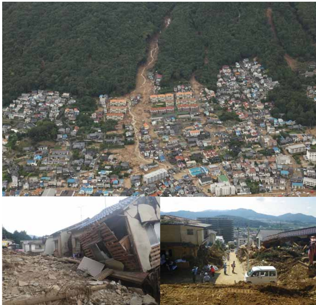
(上) 被害が大きかった八木三丁目付近で発生した土石流 (平成 26 年 8 月 20 日 撮影) (下左右とも) 阿武の里団地への土石流流入状況 (平成 26 年 8 月 31 日 撮影)
