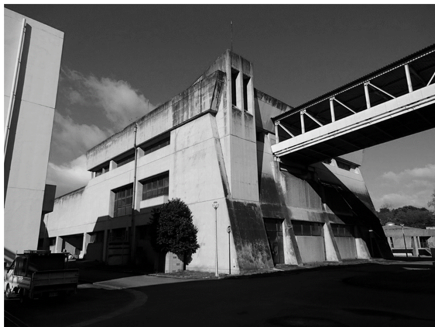
【図 旧汚泥処理棟 外観】
