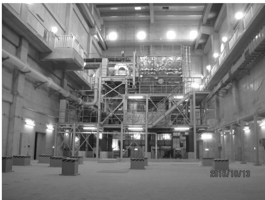
【図 セメント資源化施設 内部全景】
