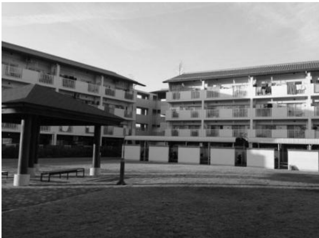
直営による県営住宅の例（小泉団地）
