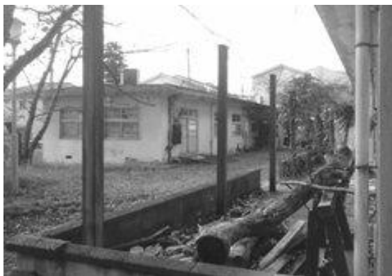
旧・太平寮跡（昭和 38 年築） 廃屋となったまま取り壊されずに残されている
