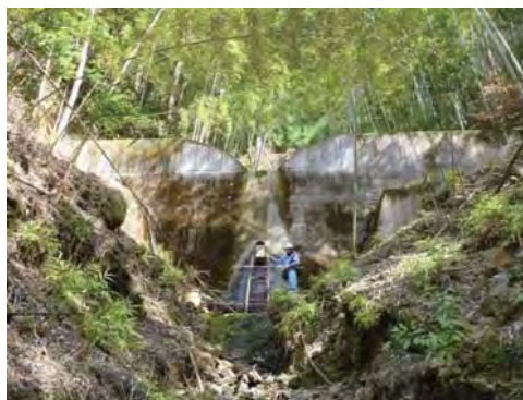
治山事業(小井地区)
