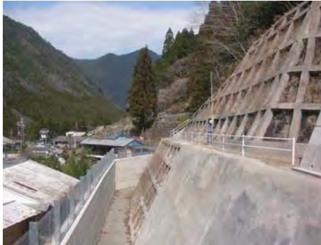
対策施設の確認
