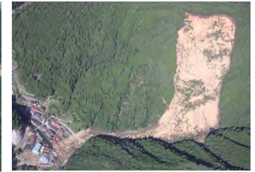
深層崩壊による土石流の被害 (野迫川村北股地区)
