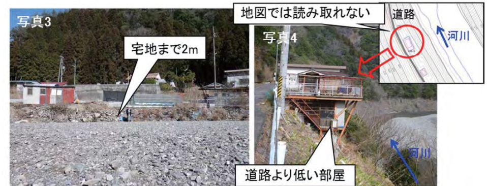
堆積土砂による河床の上昇
