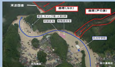
湛水による浸水被害の例 (芦瀬、冷水)
