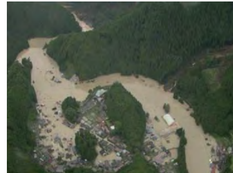
深層崩壊による河道閉塞(湛水)の被害 (天川村坪内地区)
