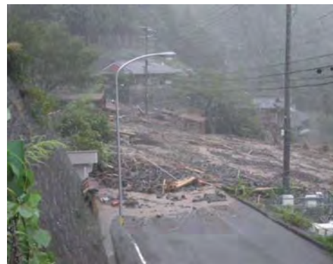
土石流による国道の寸断 (十津川村長殿地区)
