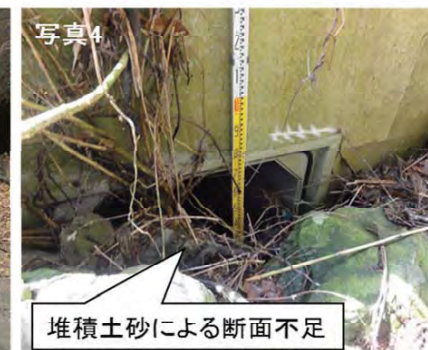
避難路の安全性 道路横過部の状況
