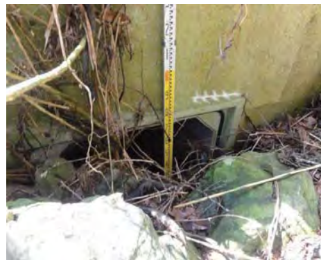
道路横断構造物の状況
