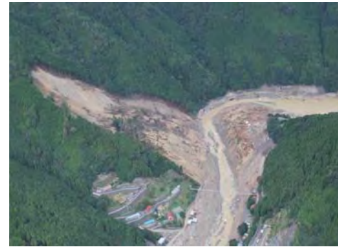
深層崩壊による対岸での被害 (五條市大塔町宇井・清水地区)
