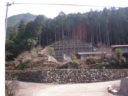
急傾斜地崩壊対策事業(小井地区)
