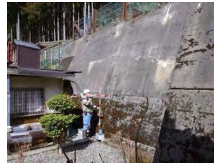
急傾斜地崩壊対策事業(和田地区)
