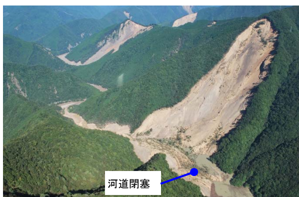
【深層崩壊(赤谷地区)の河道閉塞状況】
