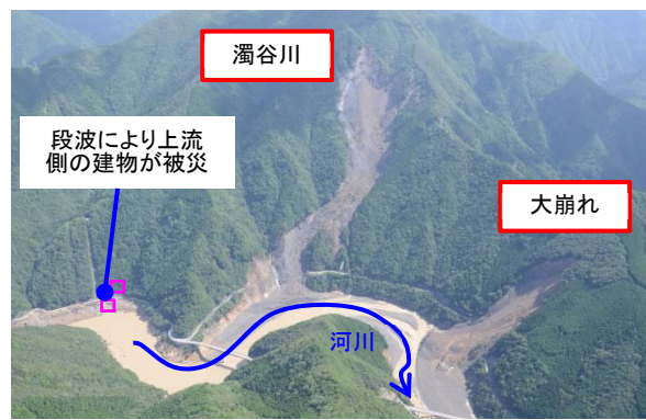
【深層崩壊(濁谷川地区)による被害状況】
