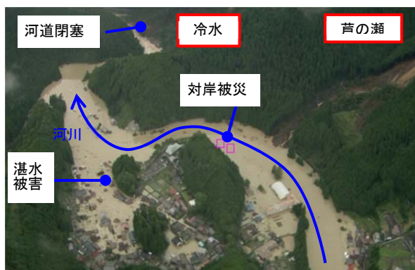
【深層崩壊(坪内地区)による被害状況】
